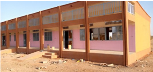
Bâtiment de quatre salles de classe
