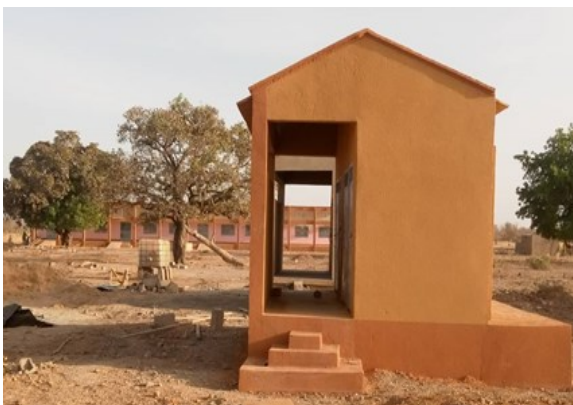
Un bloc toilettes
